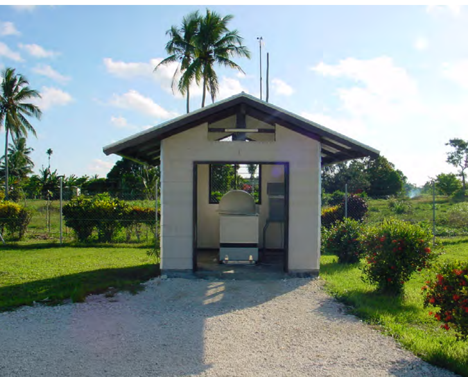
Сотрудники Отдела МСМ посетили станцию RN51 для профилактического обслуживания, а также для поиска и устранения неисправностей.
