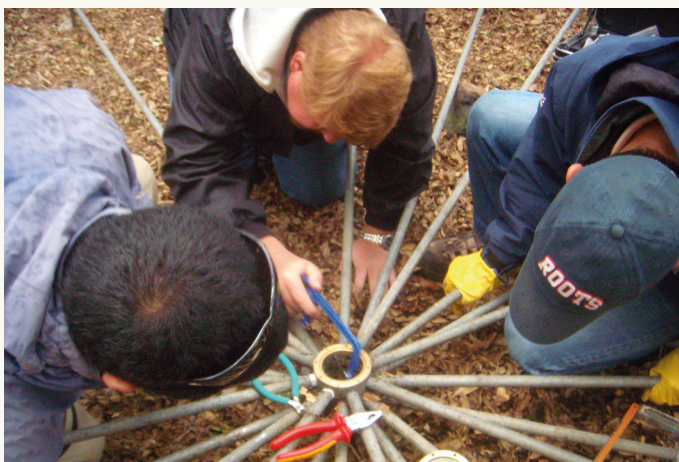
TRAVAUX D'ENTRETIEN À LA STATION DE SURVEILLANCE DES INFRASONS IS14 SUR L'ARCHIPEL JUAN FERNÁNDEZ (CHILI)
