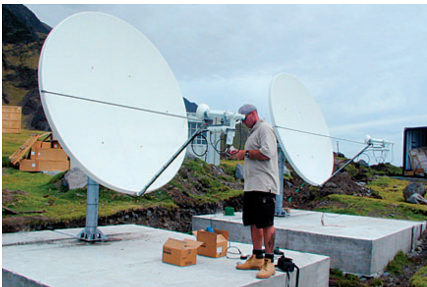
Microstations terriennes en cours de construction et (ci-contre) opérationnelles à Tristan da Cunha (Royaume-Uni), où sont situées la station de surveillance des infrasons IS49 et la station de surveillance des radionucléides (gaz rares) RN66.
