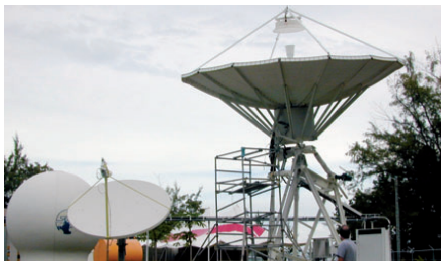
Microstation terrestre de l'ITM (petite parabole) transmettant des données par satellite entre la station de surveillance hydroacoustique HAB, située sur Diego Garcia, dans l'archipel des Tchagos (Royaume-Uni), et le CID situé à Vienne.
