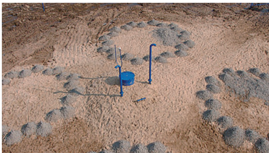
Station de surveillance des infrasons IS43 située à Doubna (Fédération de Russie).
