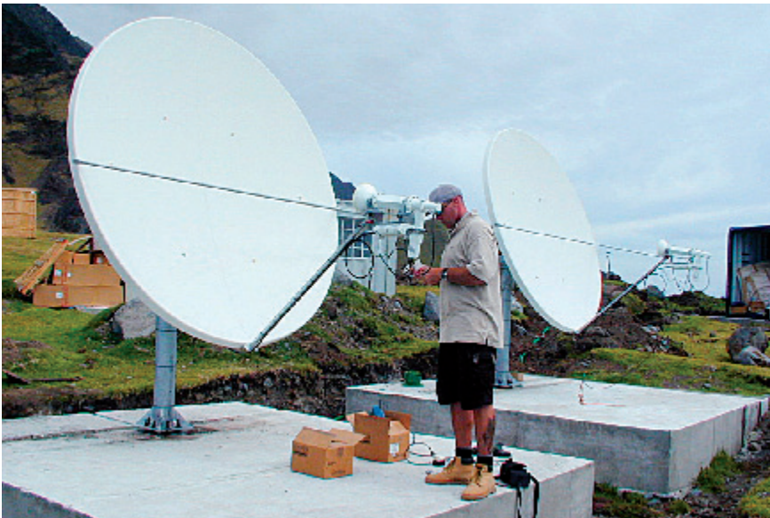
محطات طرفية ذات فتحة صغيرة جداً قيد التركيب و(على الصفحة المواجهة) بعد التركيب في تريستان كونا (المملكة المتحدة)، موقع محطة الرصد دون السمي IS49 ومحطة رصد النويات المشعة للغازات الخاملة RN66.
