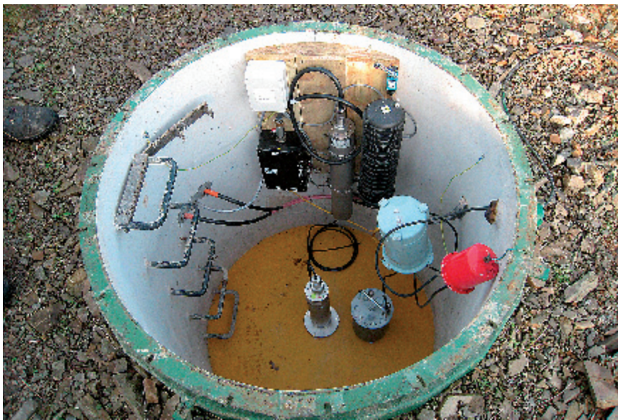
إحدى الحفر التجهيزية التي تشكل صفيحة رصد سيزمي في محطة الرصد السيزمي المساعدة AS104، في إيسكاليموير، المملكة المتحدة.
