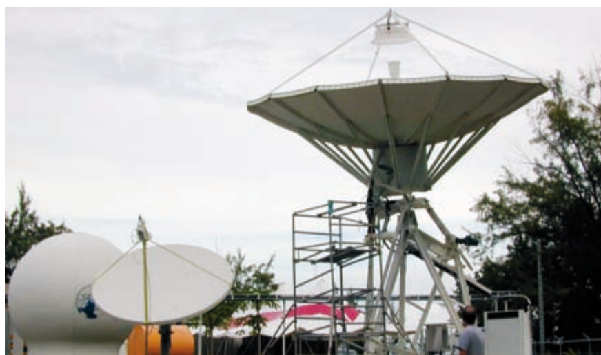
全球通信基础设施甚小口径终端天线（小碟形），通过卫星将位于（联合王国）查戈斯群岛迪戈加西亚岛的水声台站 HA8 的数据中转至维也纳国际数据中心。
