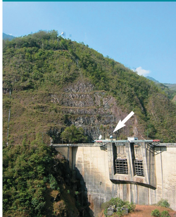
Station AS117 du réseau auxiliaire de surveillance sismologique, Santo Domingo (République bolivarienne du Venezuela).
