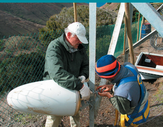
Station IS14 de surveillance des infrasons, île Robinson Crusoe (Chili).
