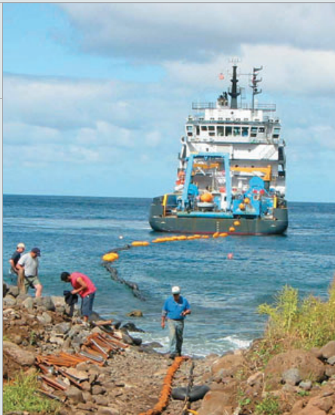
تركيب كابل قرب الشاطئ، في محطة الرصد الصوتي المائي HA3 في جزيرة خوان فرنانديز، شيلي. وتُزال في وقت لاحق الطوافات الحاملة للكابلات فوق سطح البحر مما يسمح للكابلات بالغوص إلى قعر البحر.
