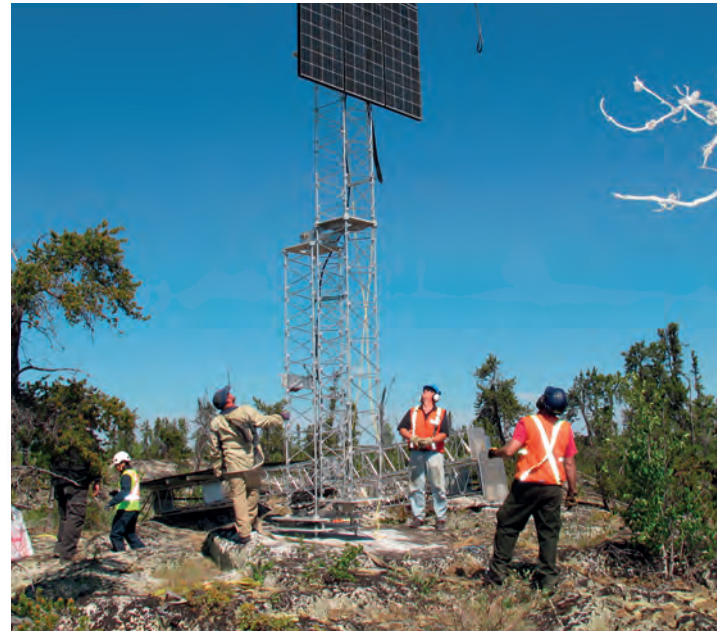
أعمال ارتقائية في المحطة PS9 التابعة لصفيحة المحطات السيزمية الرئيسية، يِلُونَايف، الأقاليم الشمالية الغربية، كندا. الصورة اليمنى: تركيب ألواح شمسية. الصورة اليسرى: تركيب حاوية للمعدات.
