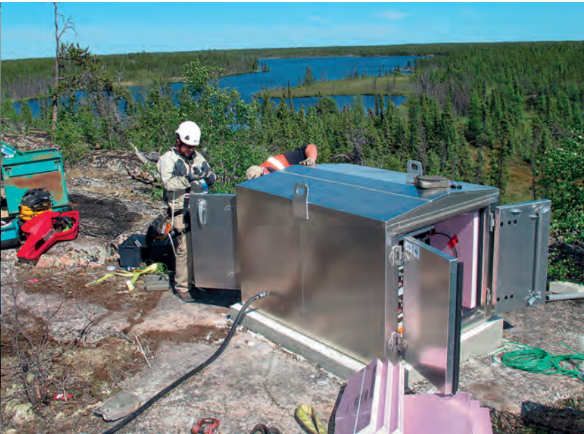
أعمال ارتقائية في المحطة PS9 التابعة لصفيحة المحطات السيزمية الرئيسية، يِلُونَايف، الأقاليم الشمالية الغربية، كندا. الصورة اليمنى: تركيب ألواح شمسية. الصورة اليسرى: تركيب حاوية للمعدات.
