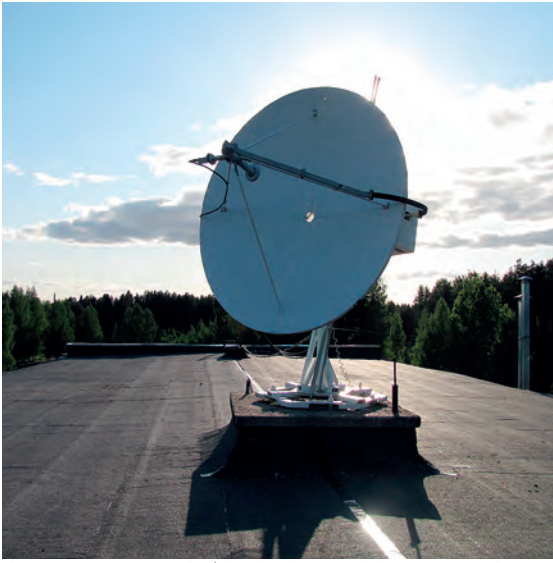
هوائي محطة طرفية ذات فتحة صغيرة جداً (VSAT) في المحطة السيزيمية المساعدة AS82، كيروف، الاتحاد الروسي.
