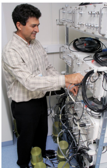
Préparation et essai du matériel destiné à une station de surveillance des infrasons.
