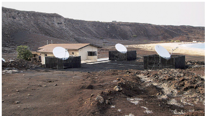
Système central d'enregistrement et antennes de communication satellitaires à la station hydroacoustique HA10, Ascension (Royaume-Uni).
