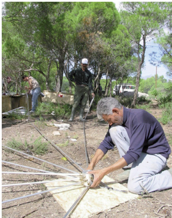
Première installation d'un dispositif de tuyaux préfabriqué fourni par le Secrétariat, station IS48 de surveillance des infrasons, Kesra (Tunisie).
