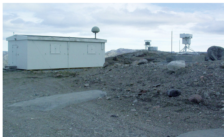
Station AS27 du réseau auxiliaire de surveillance sismologique à Søndre Strømfjord, au Groenland (Danemark).
