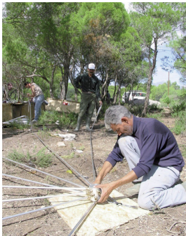
首次安装临时秘书处提供的预制管道阵列，次声台站 IS48，突尼斯 Kesra。
