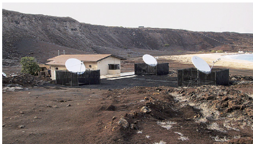
水声台站 HA10 上的中央记录设施和卫星通信天线，联合王国阿森松岛。
