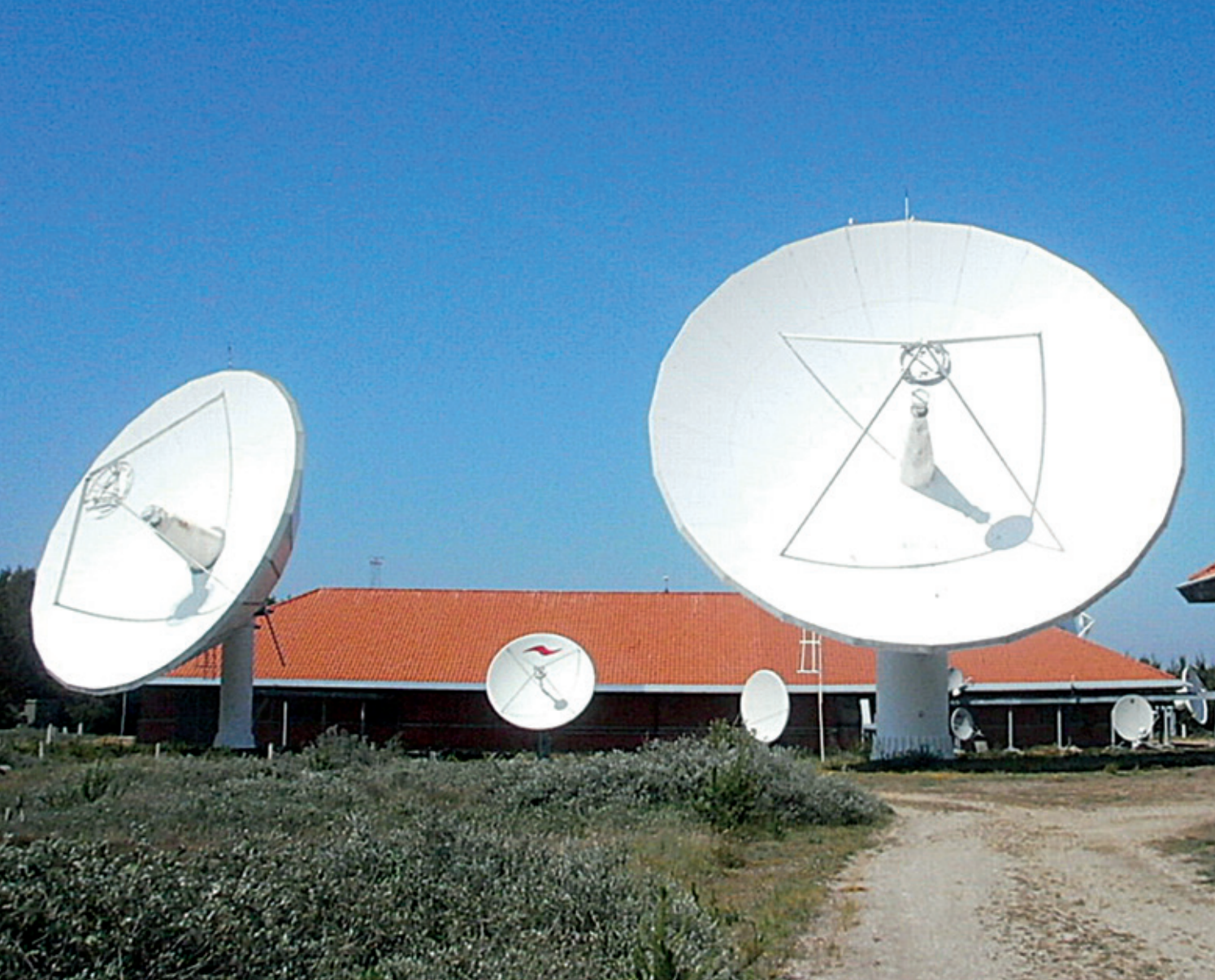
位于丹麦布拉旺德的全球通信基础设施电信港
