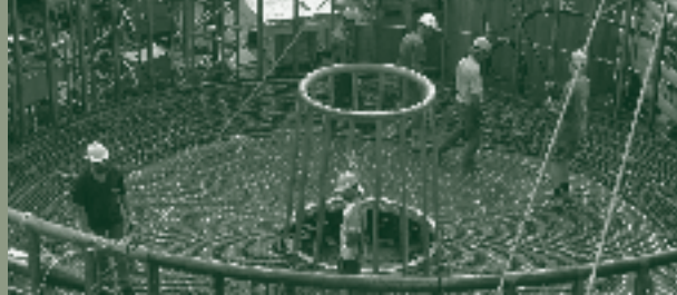
POSE DES CABLES POUR LA STATION HYDROACOUSTIQUE (HA05) EN MARTINIQUE, FRANCE
