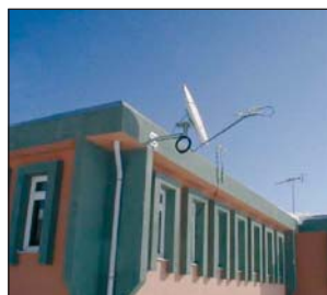
Centre national de données et station PS43, Belbashi (Turquie)
