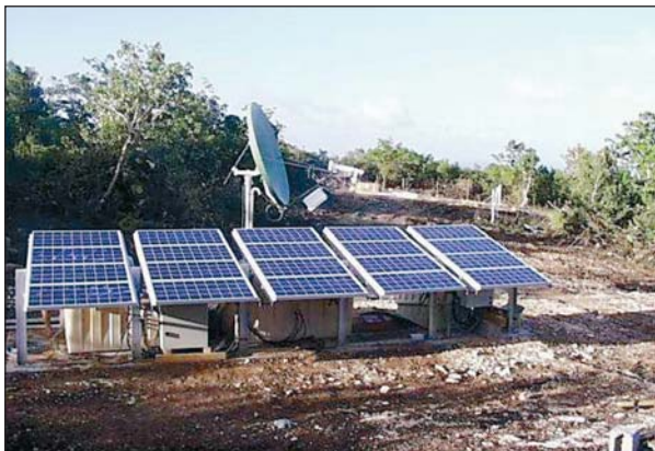
1. Panneaux solaires, blocs-batteries et antenne parabolique de l'élément méridional de la station HA5 (Guadeloupe, France), première station de détection des ondes T à avoir été certifiée (janvier 2002)
