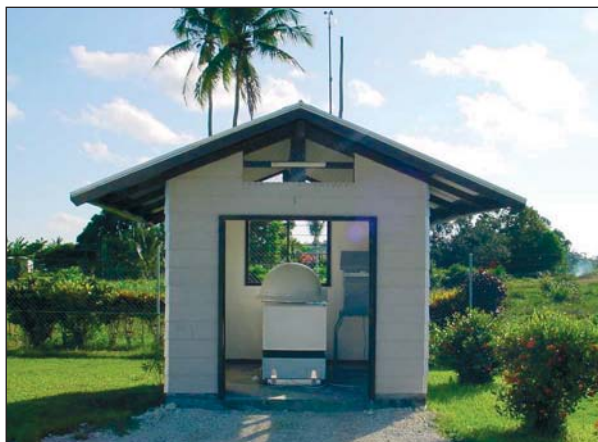
Station de surveillance des radionucléides RN51 (Kavieng, Papouasie-Nouvelle-Guinée), cliché pris lors d'une mission de certification
