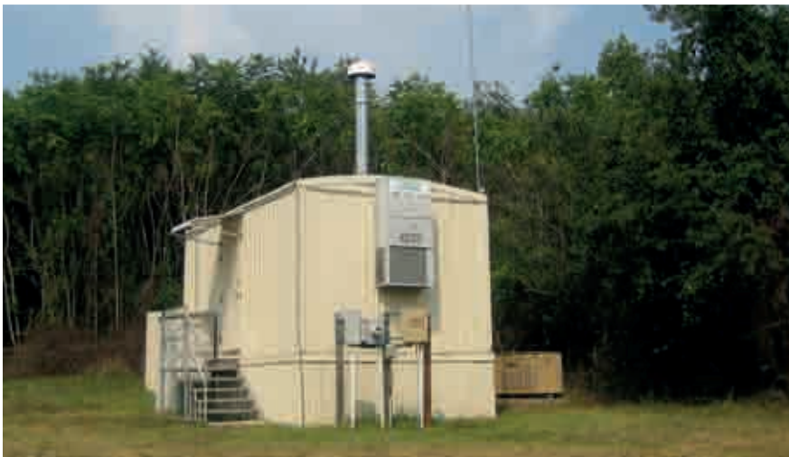
En haut: Station de surveillance des radionucléides RN68 située sur l'île de Tristan da Cunha (Royaume-Uni), dans l'Atlantique Sud, dont le système de détection des gaz rares a été certifié en décembre 2010.
