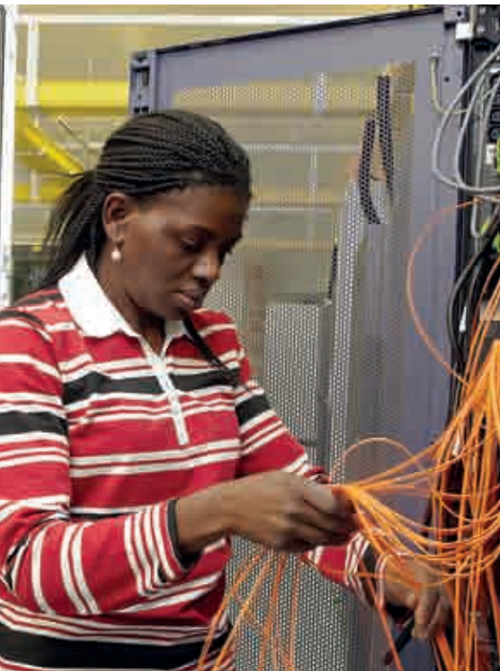
A gauche: Pose de câbles à fibres optiques en vue d'intégrer la grille de base de données dans l'infrastructure du réseau de stockage. A droite: Serveurs au centre de calcul.
