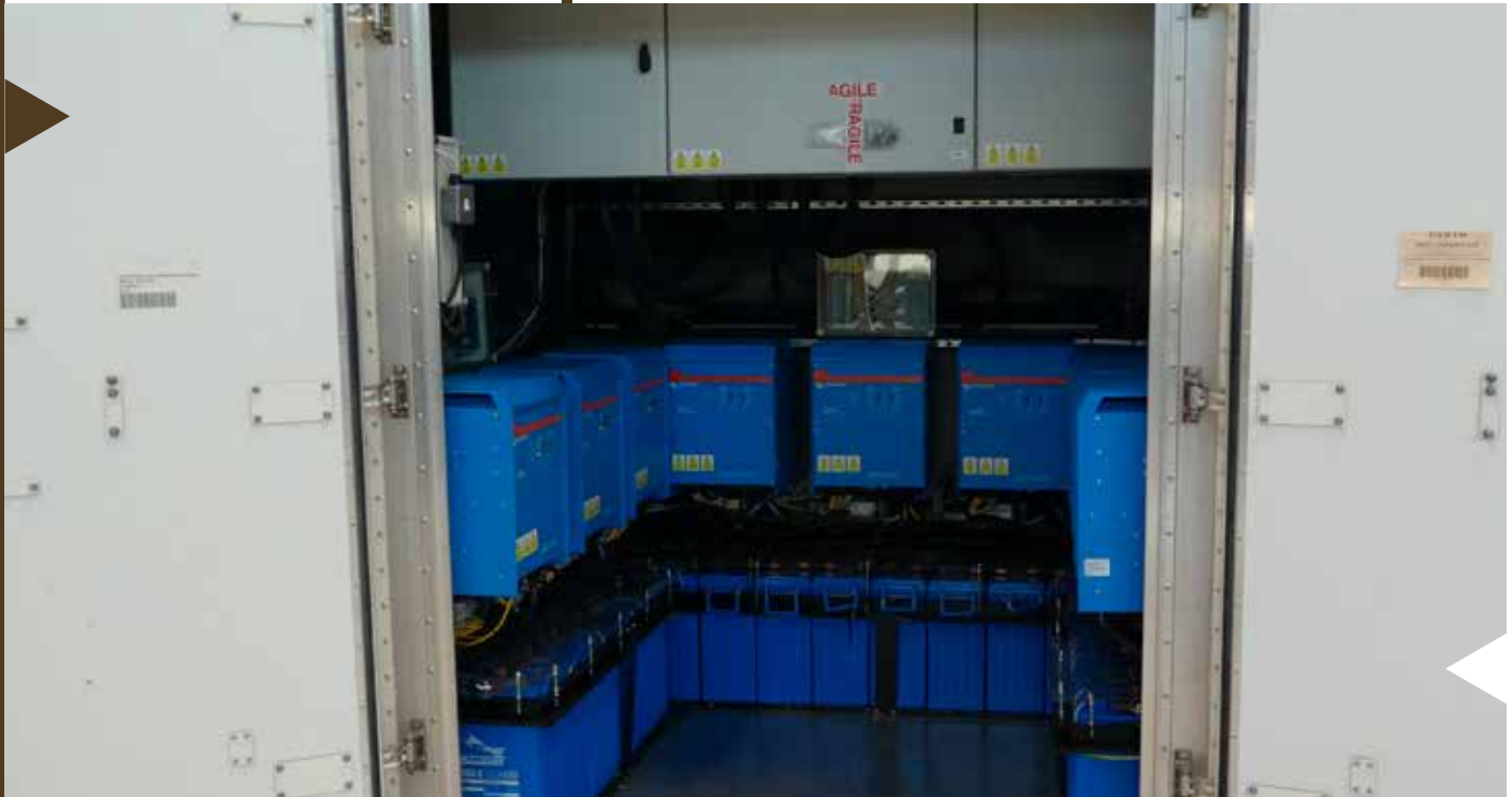
► 混合发电装置视图，集成在现场视察快速部署吊舱中，以支持以太阳能为基础的现场配电。
