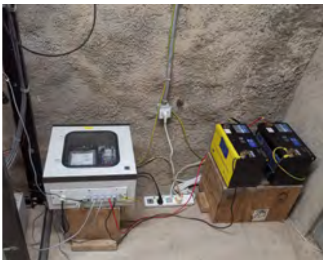
Mantenimiento correctivo en AS030 (Etiopía) financiado por la UE.
