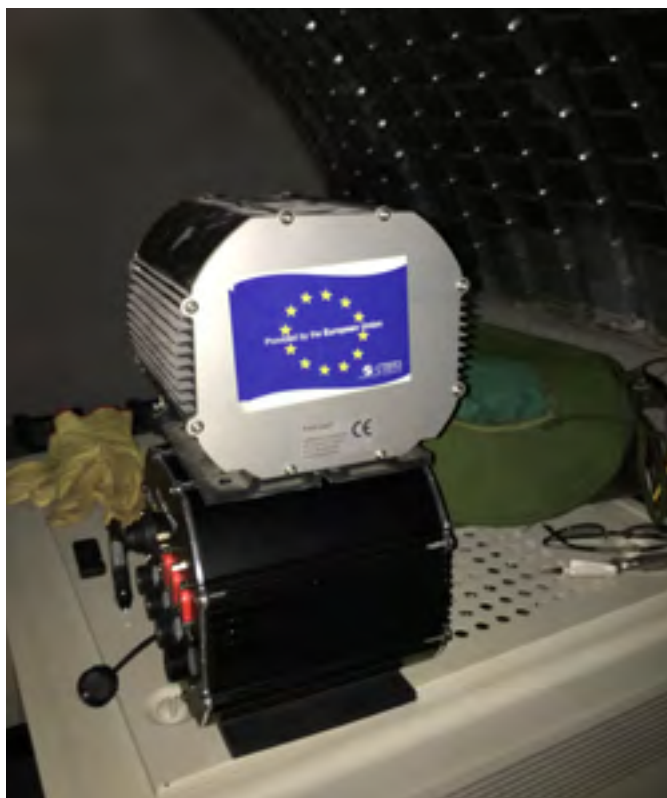
Mantenimiento correctivo en AS120 (Zimbabue) financiado por la UE.
